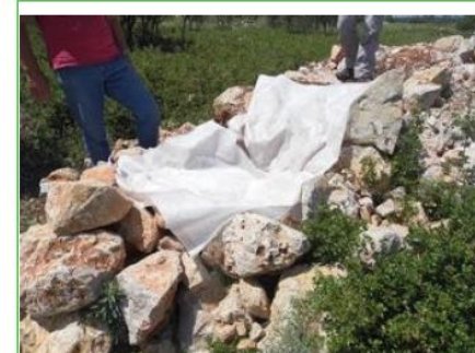
Photo 10 : Installation du géotextile ©Pauline Demonfaucon
