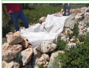
Photo 10 : Installation du géotextile ©Pauline Demonfaucon
