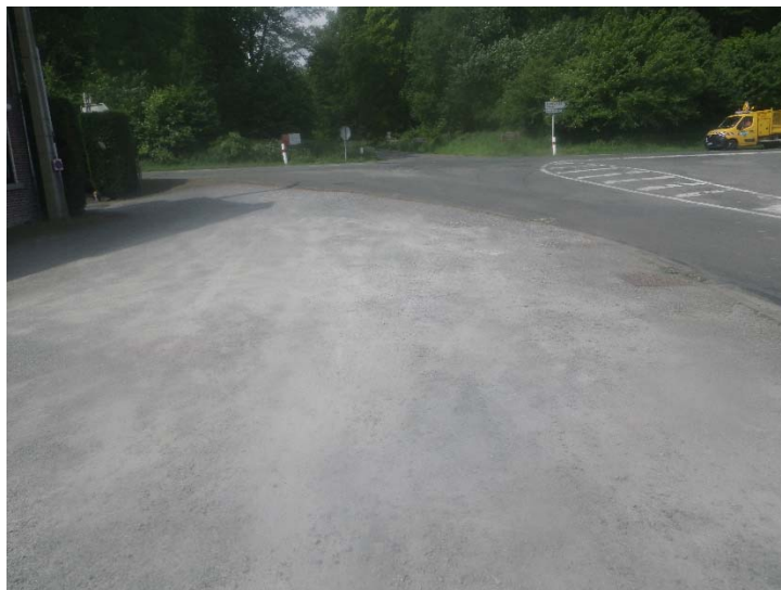
Vue sur le secteur impacté par le projet au sud-est du giratoire
