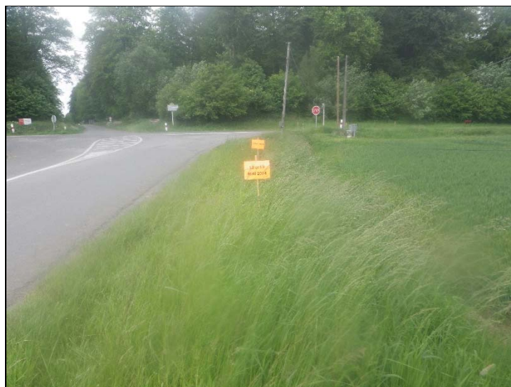
Vue sur l'accotement de ce relevé
