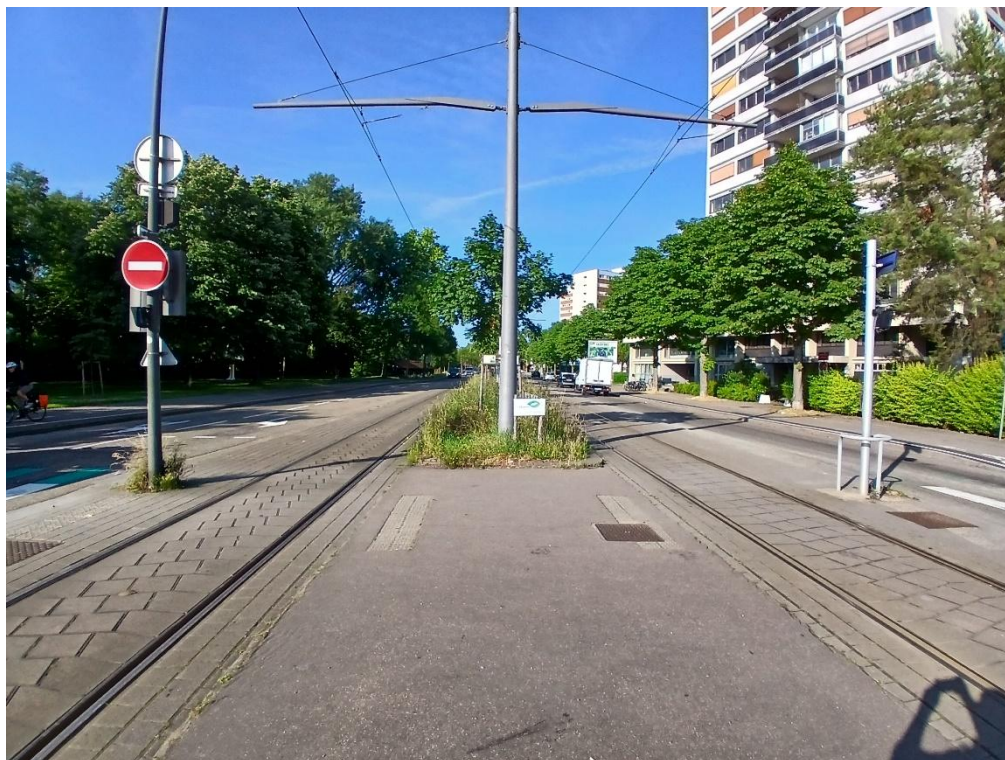
Photographie 9 : Vue sur l'avenue Pierre Mendès France vers le sud-ouest (tram B)
