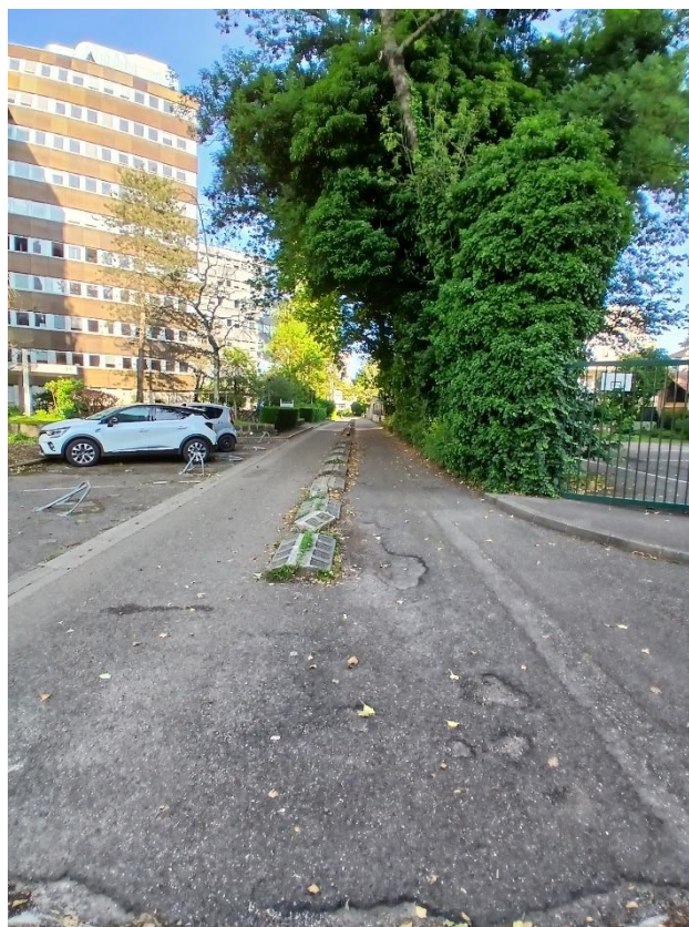
Photographie 2 : Vue sur la prolongation de la rue du Barrage au nord du site
