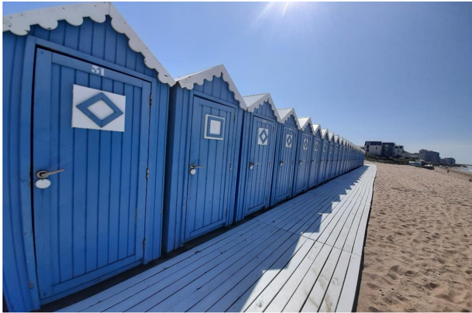
Implantation de 31 cabines de dimension 1.40x1.05x2.50 m et d'un platelage bois le long des cabines au niveau de la dune de la Garenne
