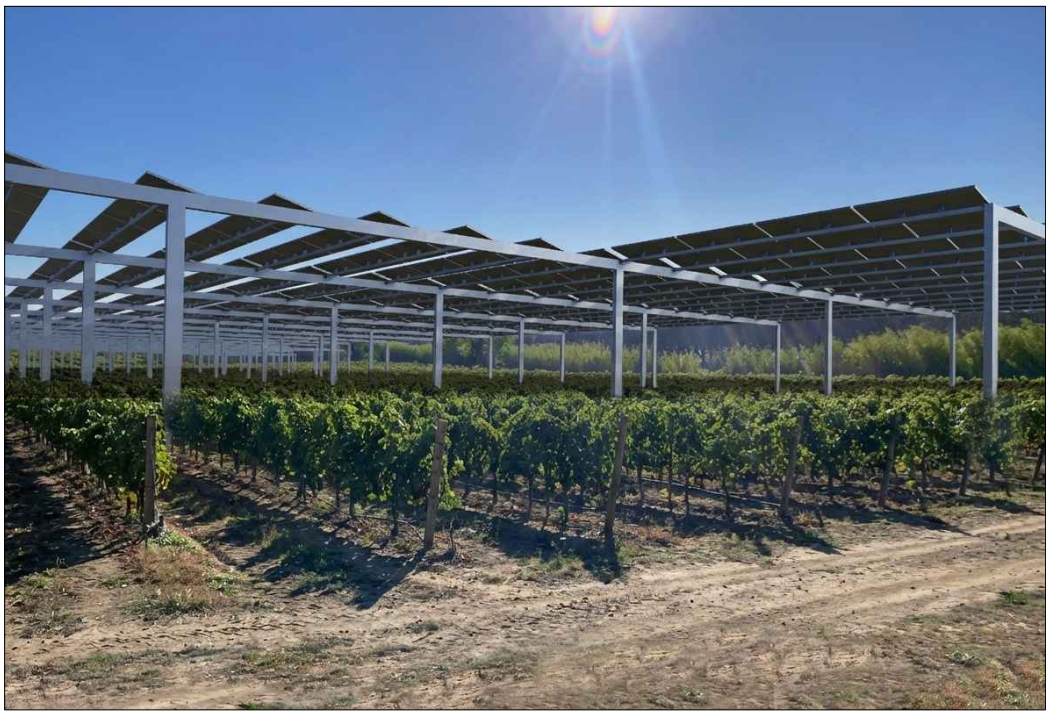
Ombrières photovoltaïques - îlot 2
