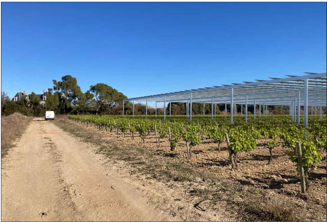
Ombrières photovoltaïques - îlot 4
