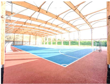
Ossature bois couverte d'une membrane
