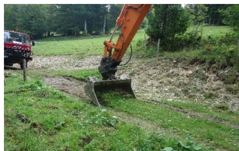
Figure : Illustration de la méthode d'étrépage de la végétation à mettre en œuvre – KARUM, 2019
