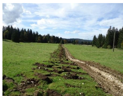
Figure : Illustration exemple de la méthode de stockage des mottes étrépiées (cas des travaux linéaires avec stockage en bord de zone de travaux) _KARUM, 2019
