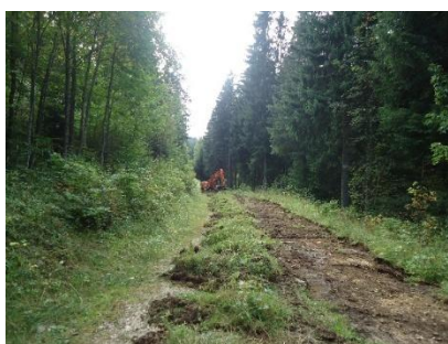
Figure : Illustration exemple de la méthode de stockage des mottes étrépiées (cas des travaux linéaires avec stockage en bord de zone de travaux) _KARUM, 2019
