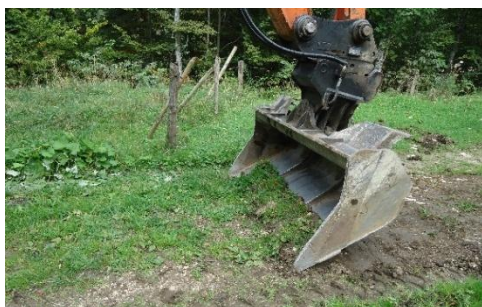
Figure : Illustration de la méthode d'étrépage de la végétation à mettre en œuvre – KARUM, 2019
