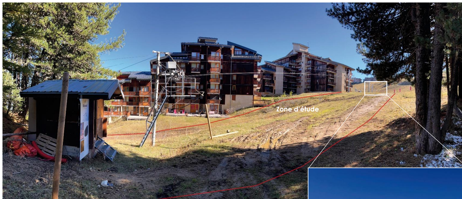
VR 2 : Aval zone d'étude immédiate
