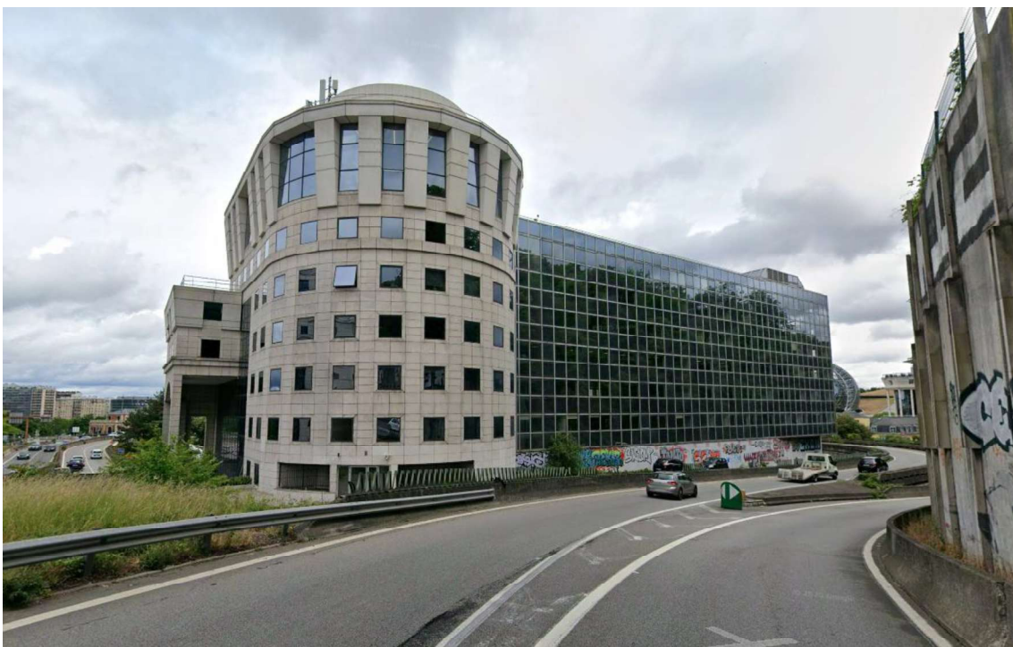
Figure 7 : Vue du bâtiment depuis la bretelle - octobre 2025 (4)
