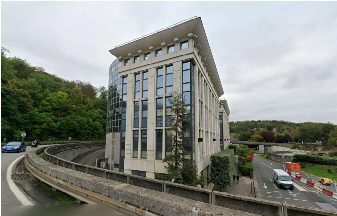
Figure 6 : Vue du bâtiment depuis la bretelle - octobre 2025 (3)
