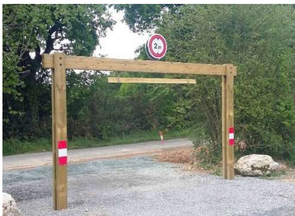
Figure 6 : portique de limitation de hauteur
