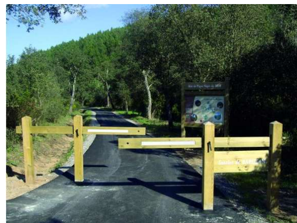
Figure 5 : barrière coulissante et potelet en chêne
