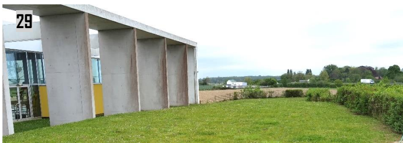
Vue sur le solarium végétal d'une surface de 1 160 m²
