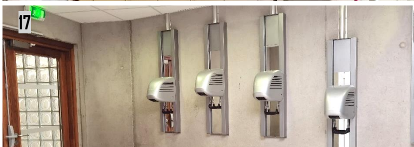
Vue sur l' espace de déchaussage et coin beauté [VC.01] des ESPACES DE VESTIAIRES COLLECTIFS [VC]
