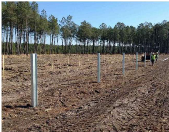
Exemple de pieux battus
