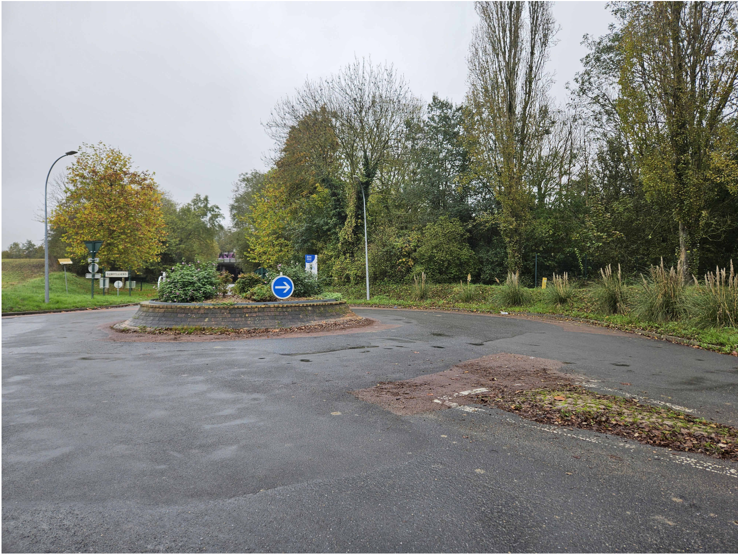
PC7_A - Vue depuis le giratoire rue Jean Jaurès
