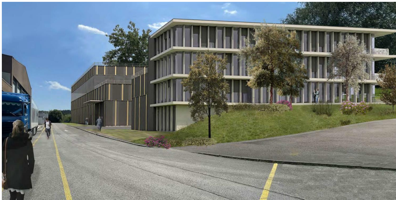
Vue sur le bâtiment de stockage et administratif
