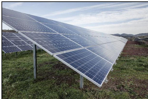
Photo 3 : Structures en pieux battus - Parc Solaire de Camares (12) – SDMD
