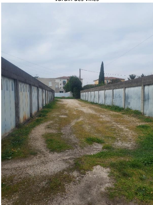
Garages à démolir
