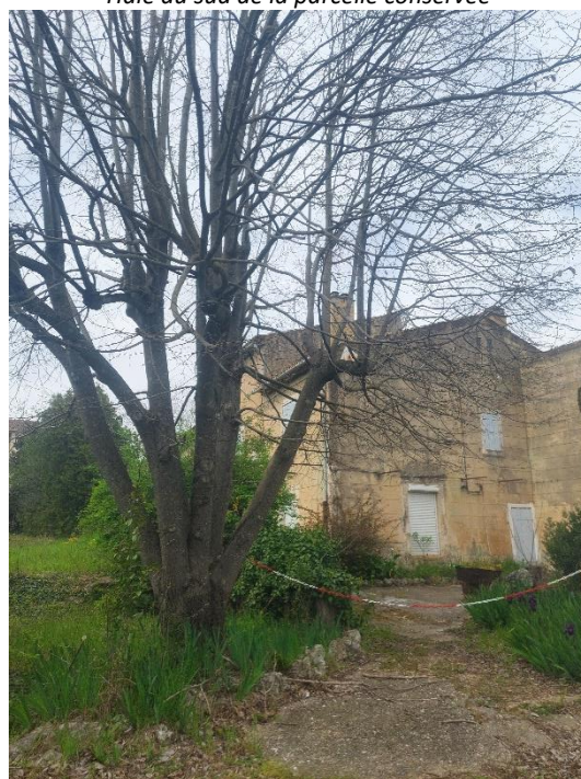
Habitation non occupée à démolir
