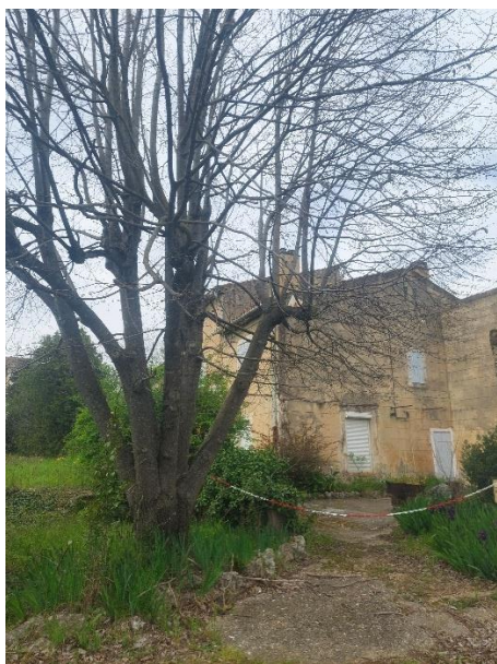
Habitation abandonnée située dans la partie Nord de l'aire d'étude rapprochée
