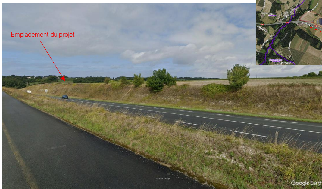
Point de vue 8 : Depuis le chemin de la Foy, avec la N141 en contrebas.
