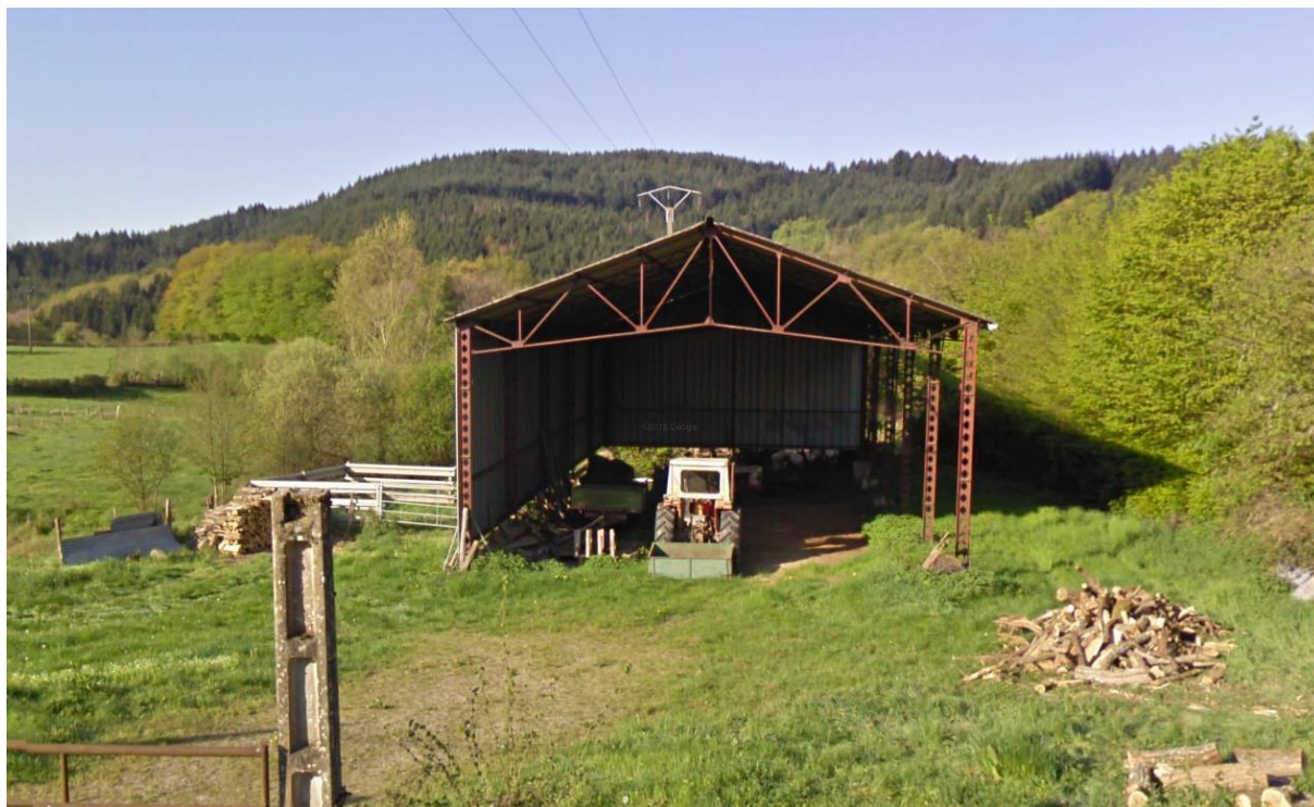
Figure 39 : Photographie du hangar de stockage (Source : Google Street View)
