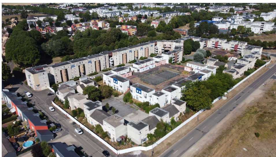
3F Normandie, vue aérienne du site avant démolition en 2023
