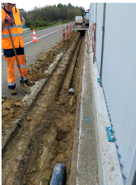
Figure 26 : Pose de la conduite en attente au niveau du pont-route
