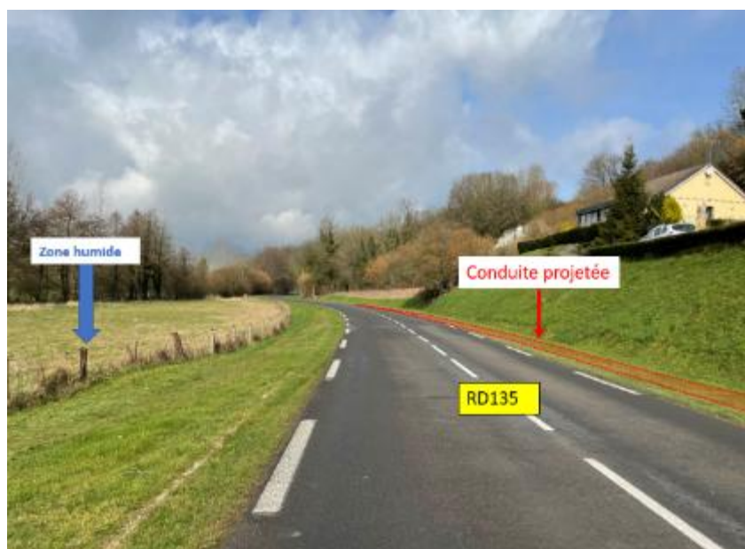
Figure 10 : Illustration des travaux à proximité de Zones Humides sur le secteur de Grumesnil
