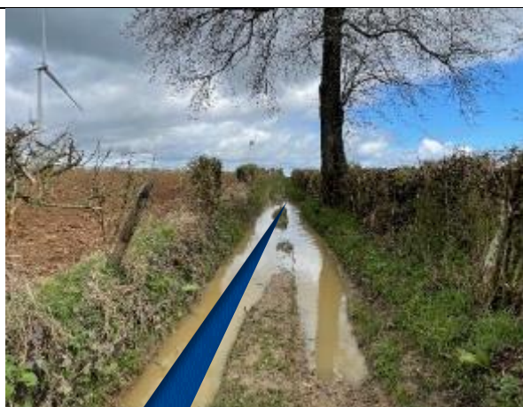
Photographie n°5 : Chemin Chasse-Marée à Gaillefontaine. Le secteur était inondé à la suite de fortes averses.
