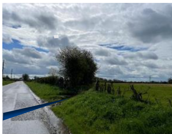
Photographie n°2 : Traversée de la RD36 et début des travaux sous le chemin du Hêtre à Conteville.
