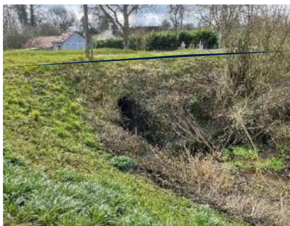
Photographie n°7 : RD135 - hameau de Mondeville. Traversée du Thérain au niveau d'une buse en acier. Il est prévu de passer au-dessus.
