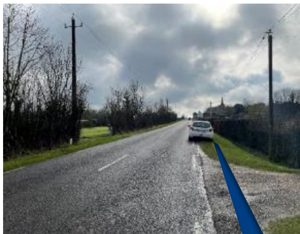
Photographie n°4 : R135 - hameau les Noyers. Des réseaux concessionnaires sont présents en accotement. L'emprise disponible semble toutefois, à ce stade, suffisante pour l'implantation de la conduite d'interconnexion.
