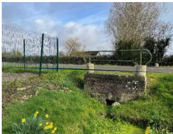
Photographie n°3 : RD135 - hameau les Noyers. Traversée d'une source de la Béthune au niveau d'un ouvrage d'art maçonné en briques. Il est prévu de passer au-dessus de l'ouvrage.
