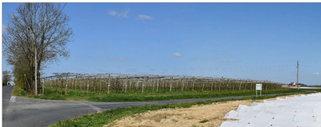
Photographie 1 : PDV 1- vue proche du sud-ouest du site d'étude depuis la RD 7 (Source : ENCIS Environnement)
