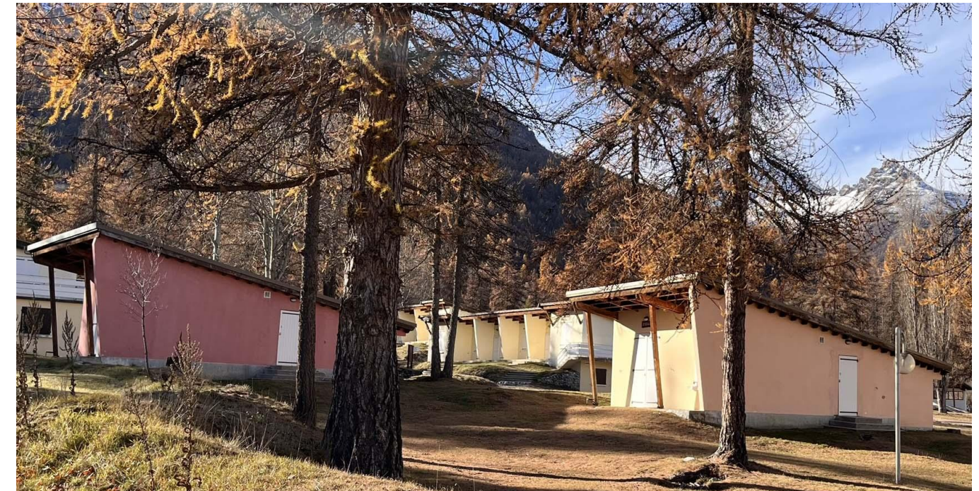
Une époque et des modes constructifs aujourd'hui datés.
