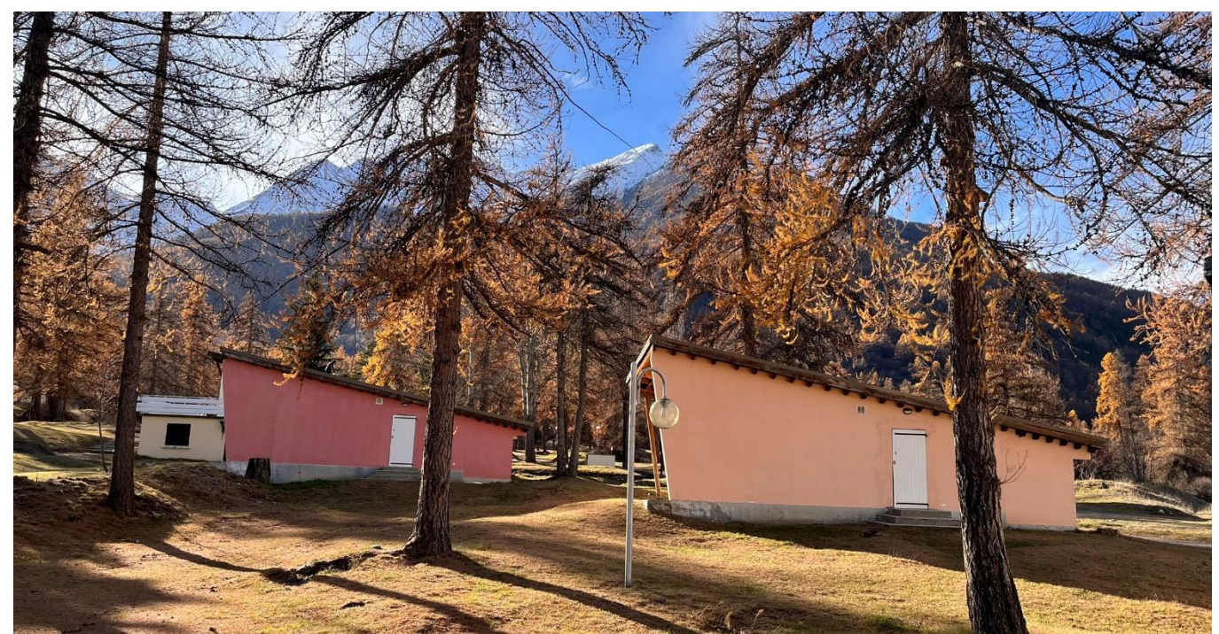
Bâtiment au sein de la strate arborée en place
