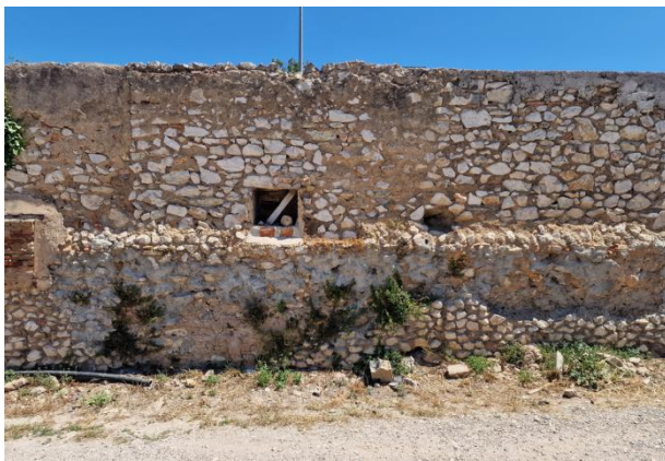
Photo 7 : Mur en pierres maçonnées (hors site de projet)
