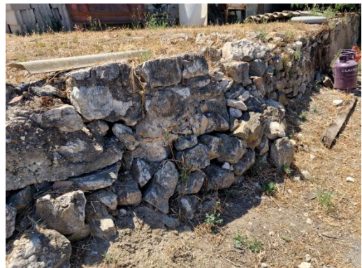
Photo 8 : Mur de pierres sèches
