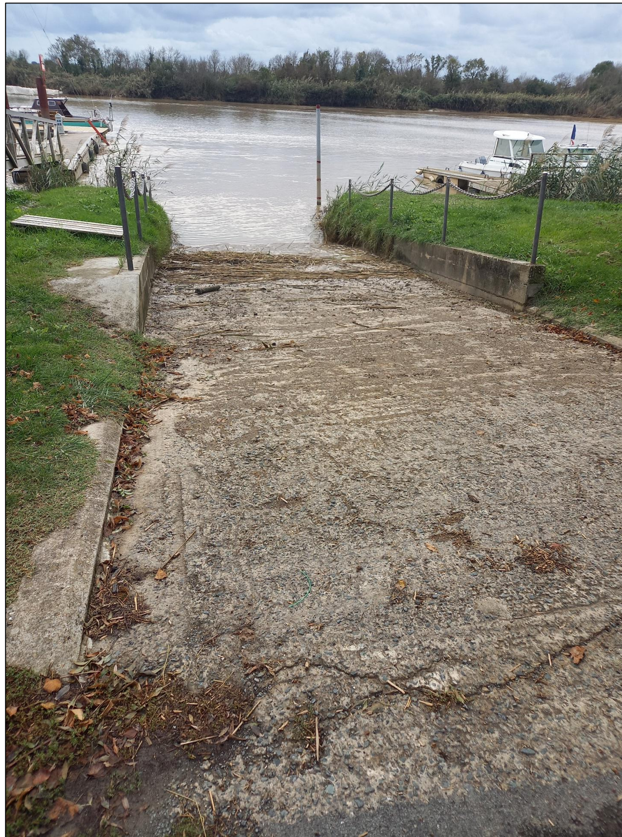
Figure 4 : Vue sur la cale de mise à l'eau (photo 3)
