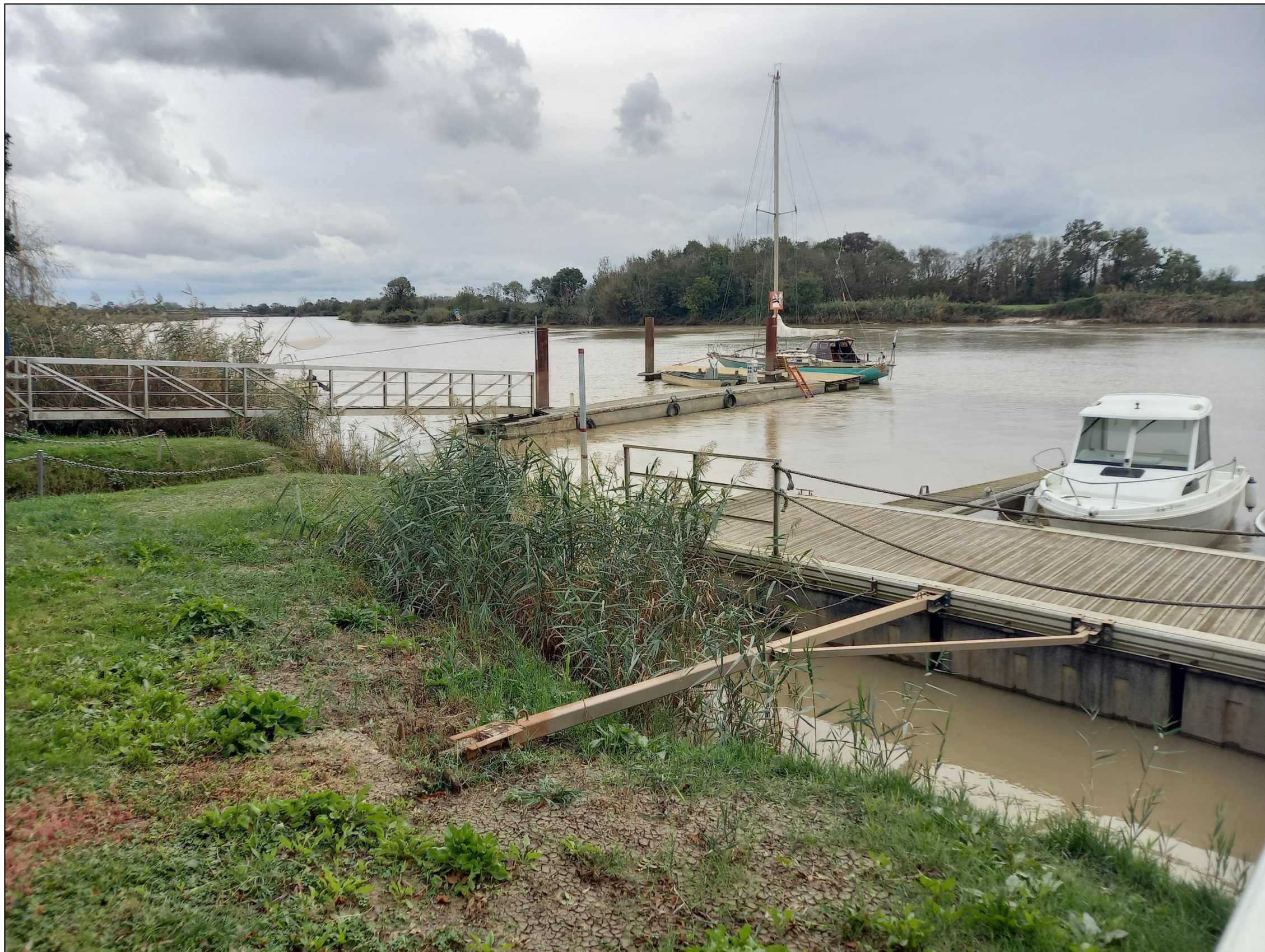
Figure 2 : Vue sur les pontons existants (photo 1)
