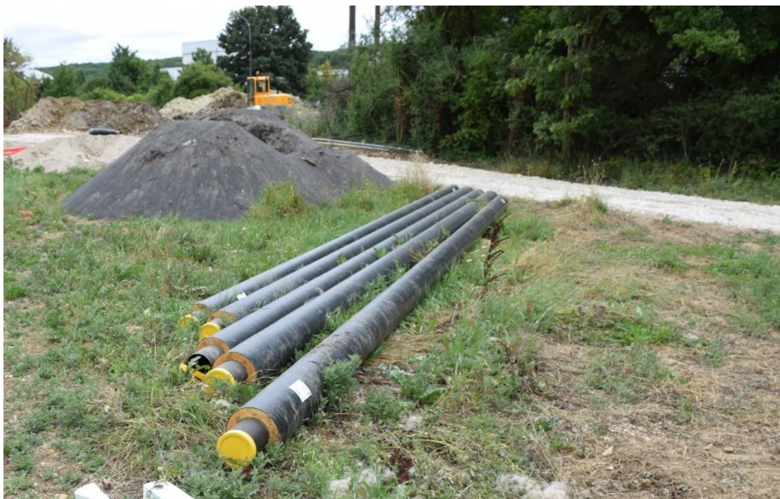
Figure 5 : Exemple de tronçons de tuyauterie pré-isolée
