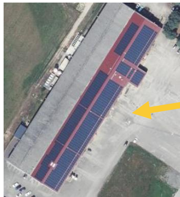
Centrale PV de Hières-sur-Amby
