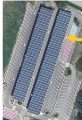
Centrale PV de La Balme-les-Grottes
