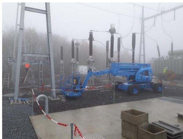
Mise en place des différents équipements HTB
