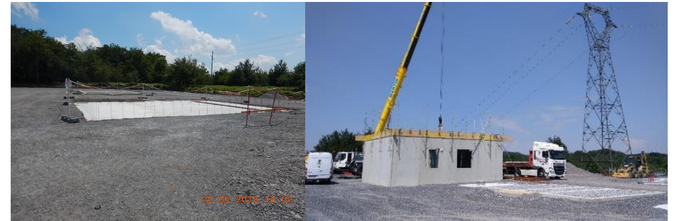
Fondation du bâtiment technique/Construction du bâtiment
