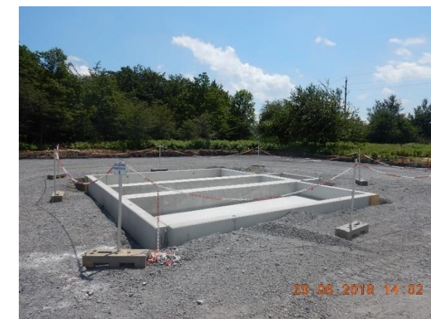
Création des fondations des transformateurs
