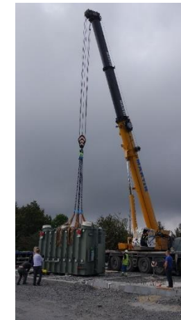
Pose du transformateur de puissance
