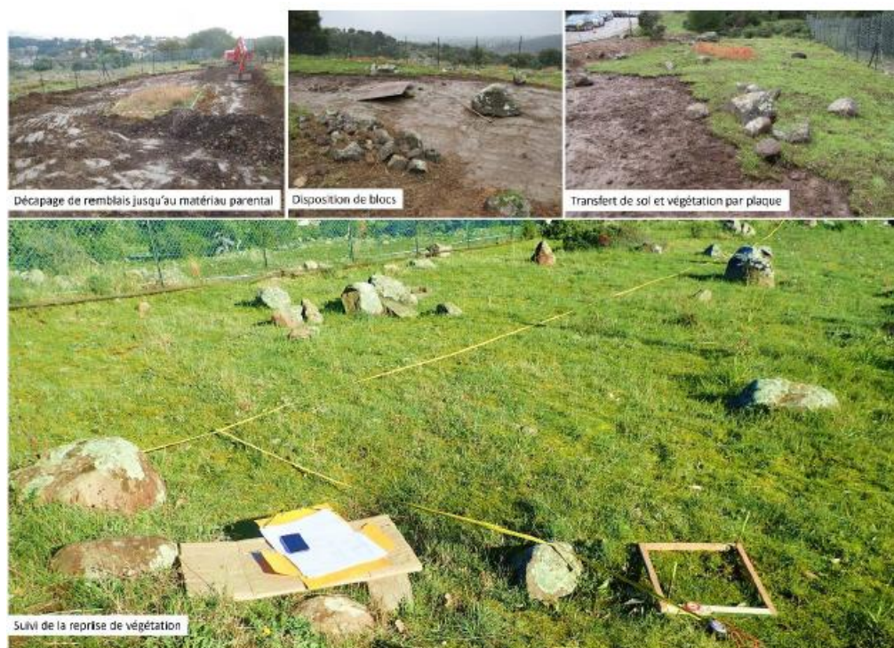
Figure 49. Exemple de réhabilitation d'ancien remblais sur le Dôme de Biot (Alpes-Maritimes) en utilisant les ressources locales (blocs, sols, végétations) (source Naturalia-Vert'Attitude)
