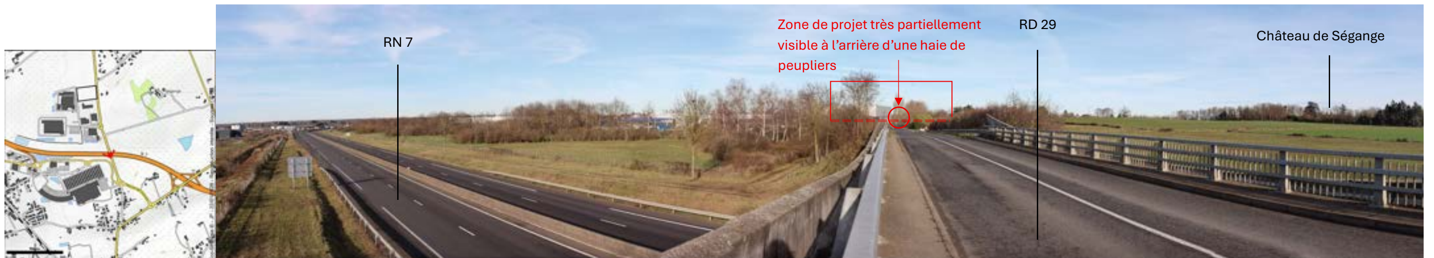
Photographie 7 – pdv 9 (Cf. Figure 5 et Figure 7). Depuis le pont de la RD 29 surplombant et franchissant la RN 7, le château de Ségange est perceptible au travers des boisements mais il n'entretient aucun lien de covisibilité avec le projet (source : Eco-stratégie 13/01/2026)
