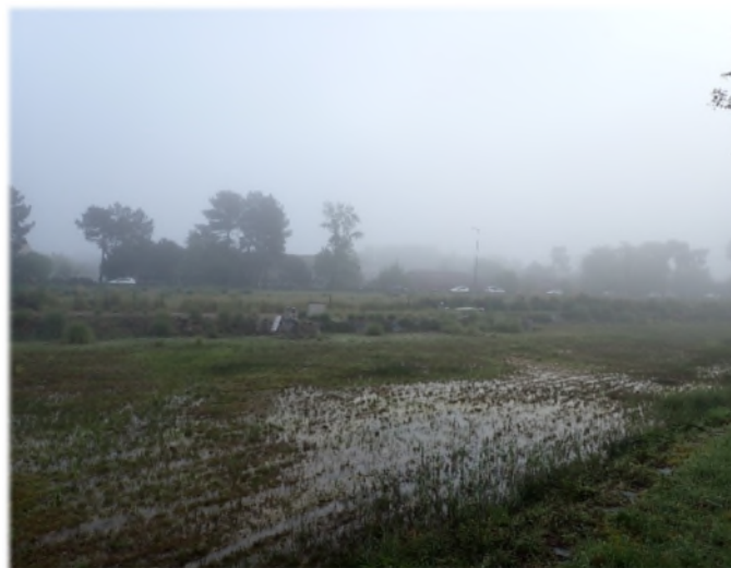
Bassin de rétention d'eau pluviale au nord de l'aire d'étude rapprochée- Artelia, 2022
