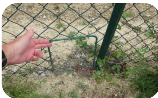
Figure 17 : Passage à petite faune – Source : Artifex
