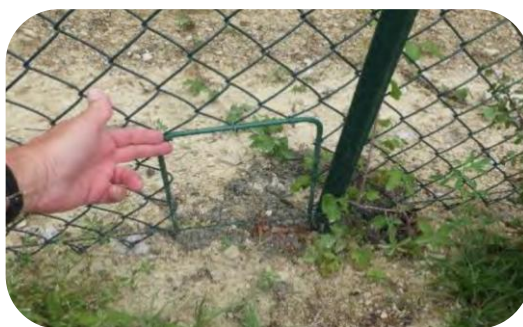
Figure 21 : Passage à petite faune - Source : Artifex
