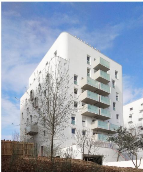
ARCHIKUBIK, LOGEMENTS, EMERIGE, ZAC ROUGET-DE-LISLE, VITRY-SUR-SEINE
