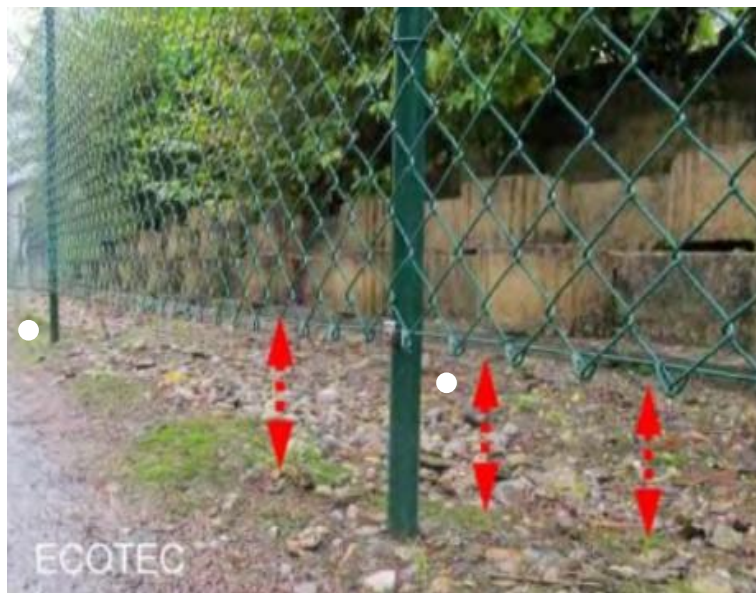
Exemples de clôtures permettant le passage de la petite faune © Ecotec
