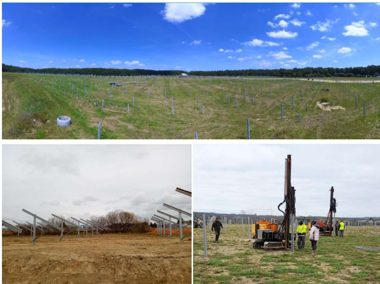
Figure 1 : Mise en place des pieux battus
