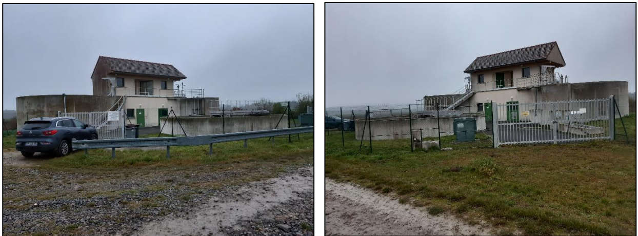
Figure 66 Vue sur les portails de la station
