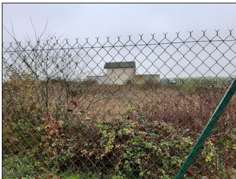
Figure 30 Vue sur la zone d'infiltration à l'arrière
