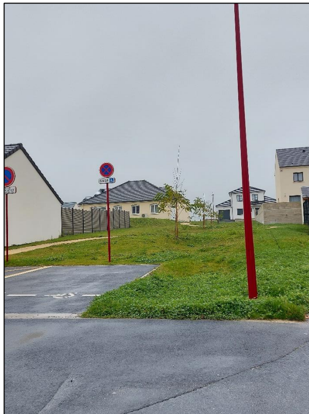
Figure 23 Vue sur la noue rue Pierre Barré
