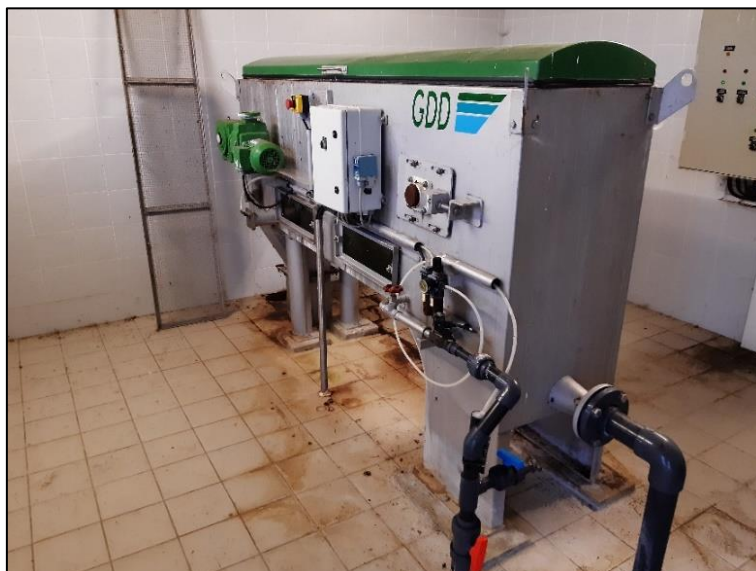
Figure 54 : Vue de la GDD
