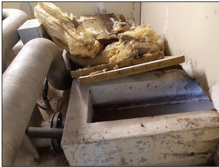
Figure 38 Vue sur la sortie du dégrilleur
