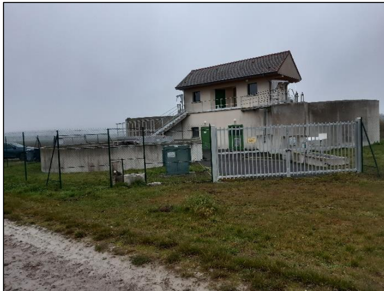
Figure 60 Vue sur le bâtiment d'exploitation
