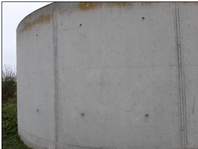
Figure 64 Vue sur le génie civil du bassin d'aération
