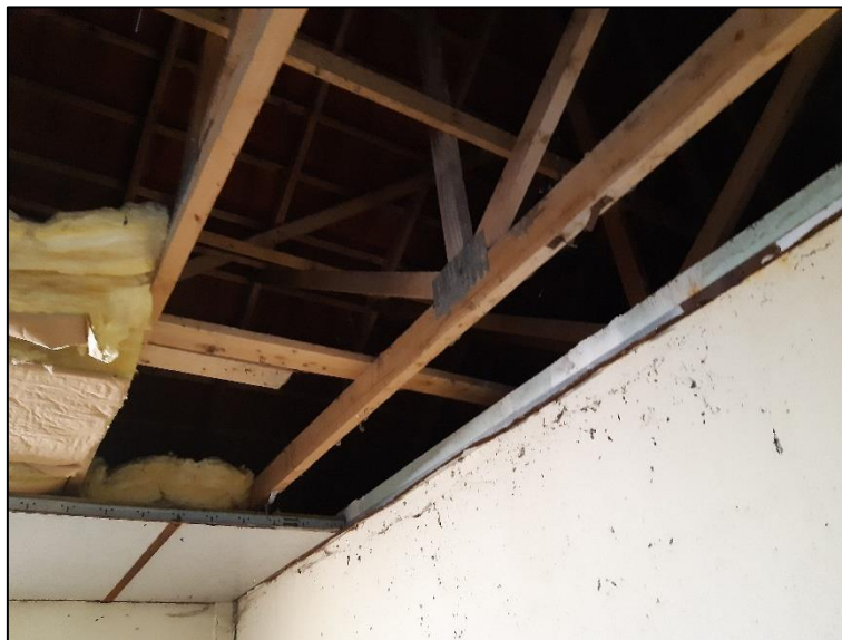
Figure 39 Vue sur la charpente
