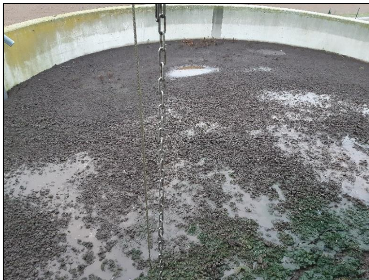
Figure 56 : Silo à boues rempli le jour de la visite
