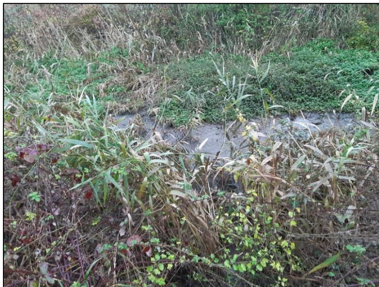
Figure 51 Vue sur les dépôts de l'aire d'infiltration
