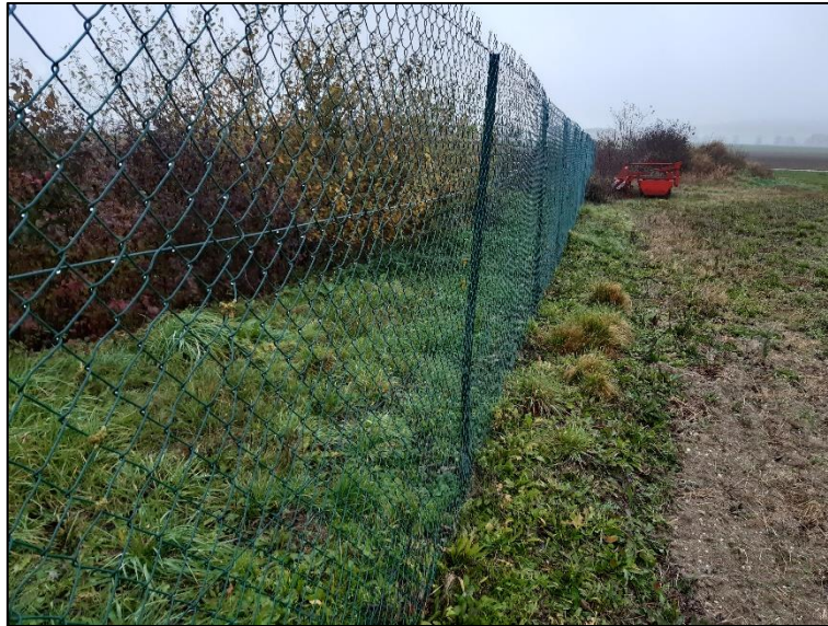
Figure 65 Vue sur la clôture de la station
