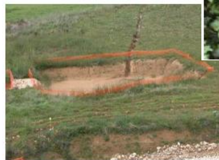
Tranchée d'écoulement vers bassin de décantation
