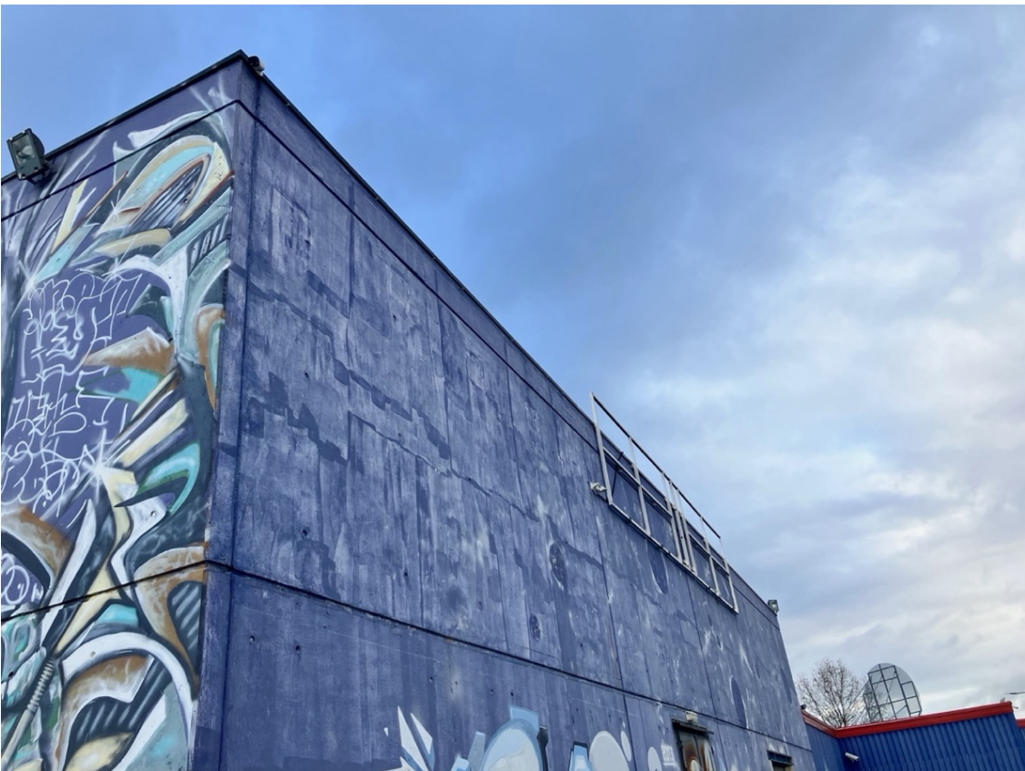
Illustration 10 : Espace entre avancé de toit et façade – Source ARCHIMED Environnement – 20/11/2025
