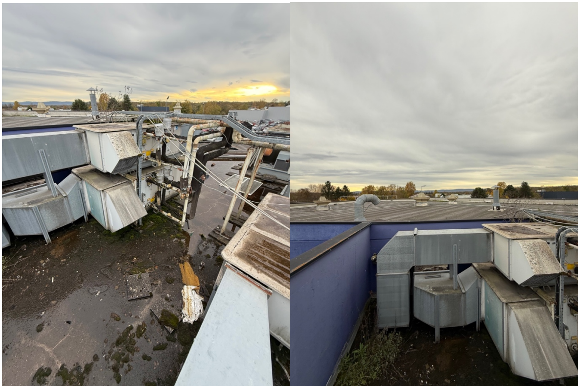
Illustration 12 : Vue sur le toit- Source BLUE PARK – 17/12/2025
