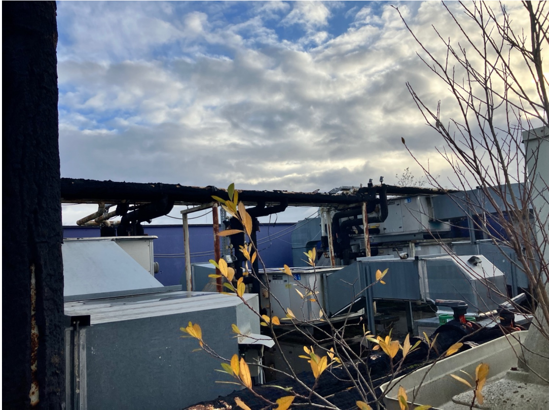
Illustration 11 : Vue sur le toit- Source ARCHIMED Environnement – 20/11/2025
