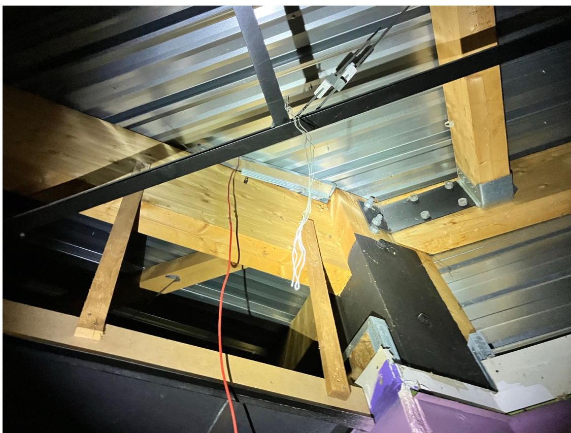
Illustration 14 : Toiture et charpente du bâtiment – Source ARCHIMED Environnement – 20/11/2025
