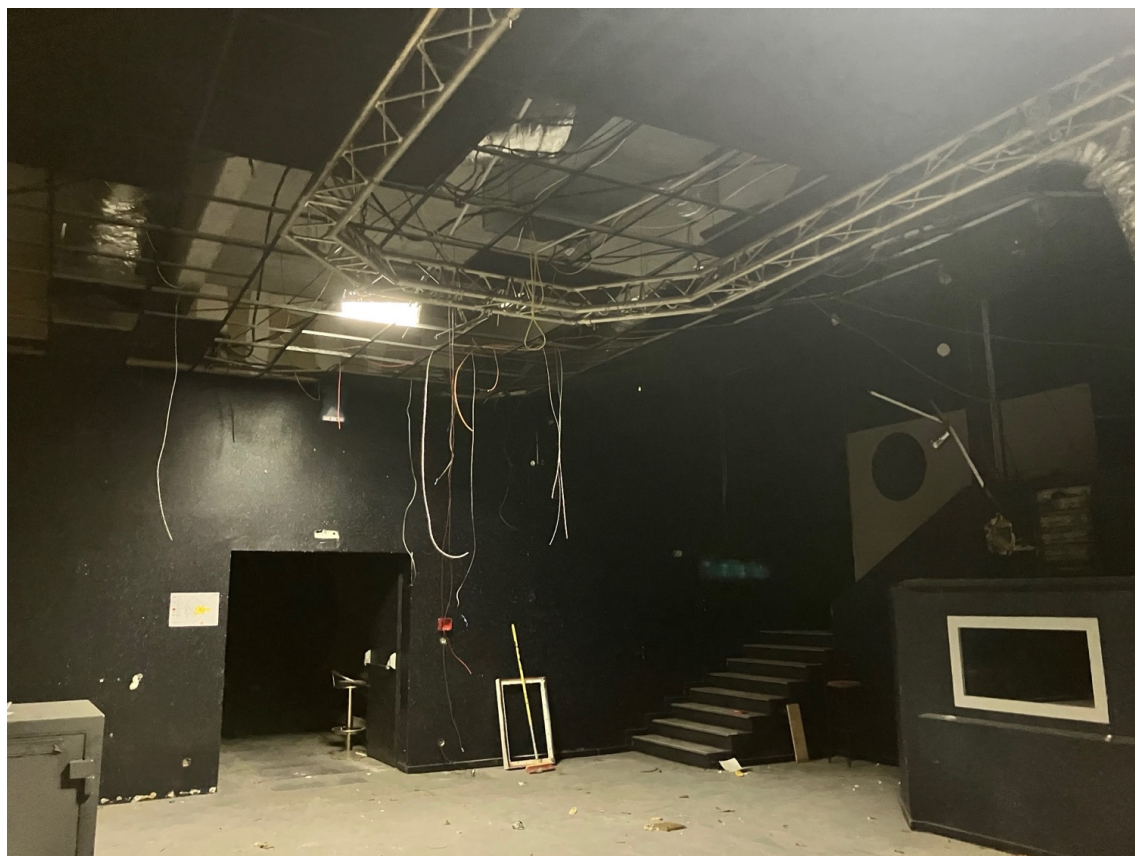
Illustration 16 : Intérieur du bâtiment non utilisé – Source ARCHIMED Environnement – 20/11/2025
