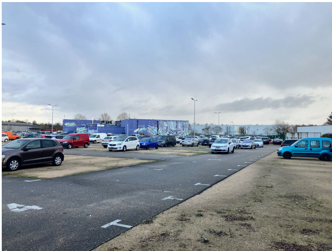
Illustration 1 : Vue 1 du bâtiment depuis le parking depuis le Nord-Ouest– Source ARCHIMED Environnement – 20/11/2025
