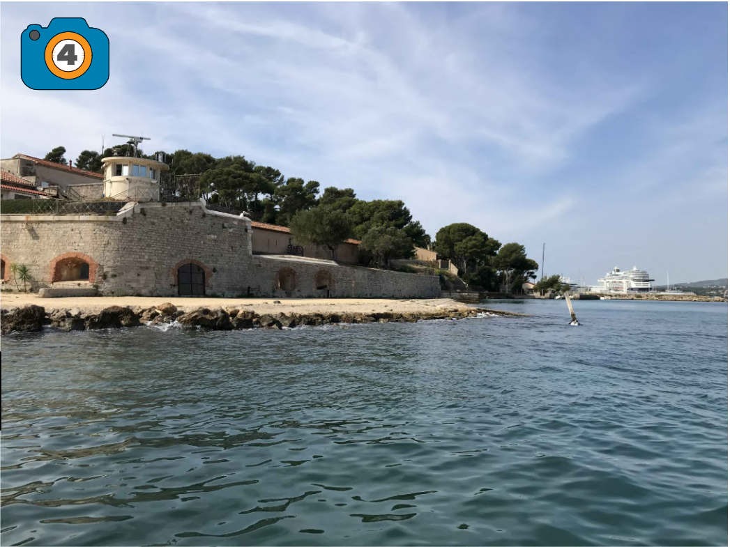
Nous constatons un petit talus de protection en enrochements 0.5 / 2 T tout au tour du Fort de L'Eguillette
