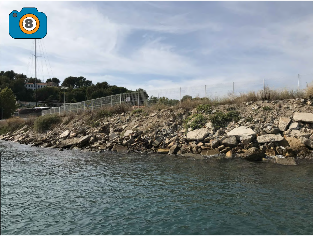
Nous constatons que le côté extérieur de la digue de protection "Monaco Marine" est constitué d'éléments de démolition en béton (dalle, éclats, remblais, ferraille, ...) et d'enrochements filtre. La zone de marnage ne comporte pas de fines, celles-ci ont été dispersées sous l'effet des vagues.
