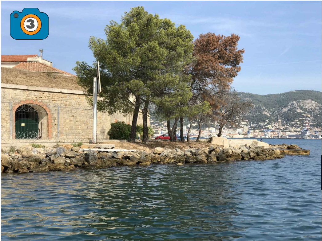
Nous constatons un petit talus de protection en enrochements 0.5 / 2 T tout au tour du Fort de L'Eguillette
