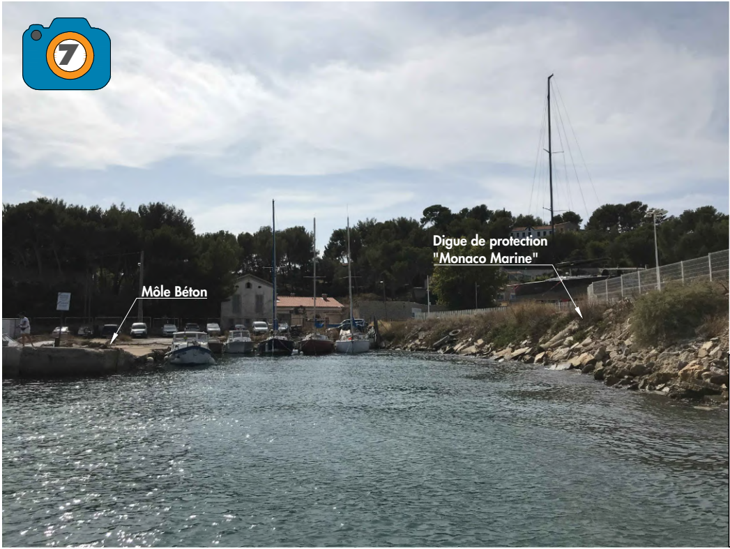
Nous constatons que le côté extérieur de la digue de protection "Monaco Marine" est constitué d'éléments de démolition en béton (dalle, éclats, remblais, ferraille, ...) et d'enrochements filtre. La zone de marnage ne comporte pas de fines, celles-ci ont été dispersées sous l'effet des vagues.
