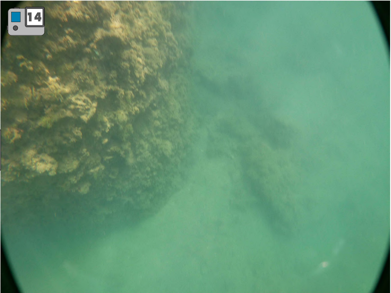
La partie avant de la darse en pied d'ouvrage ne comporte pas d'affouillement, une hauteur d'eau plus conséquente est constatée.
