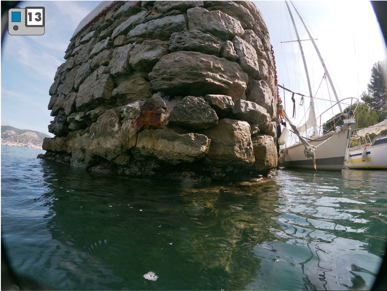
La partie avant de la darse en pied d'ouvrage ne comporte pas d'affouillement, une hauteur d'eau plus conséquente est constatée.
