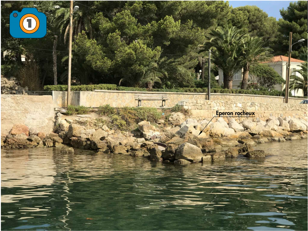
Eperon rocheux ou promontoire entièrement déstructuré réalisé en enrochements 100/300 kg.
