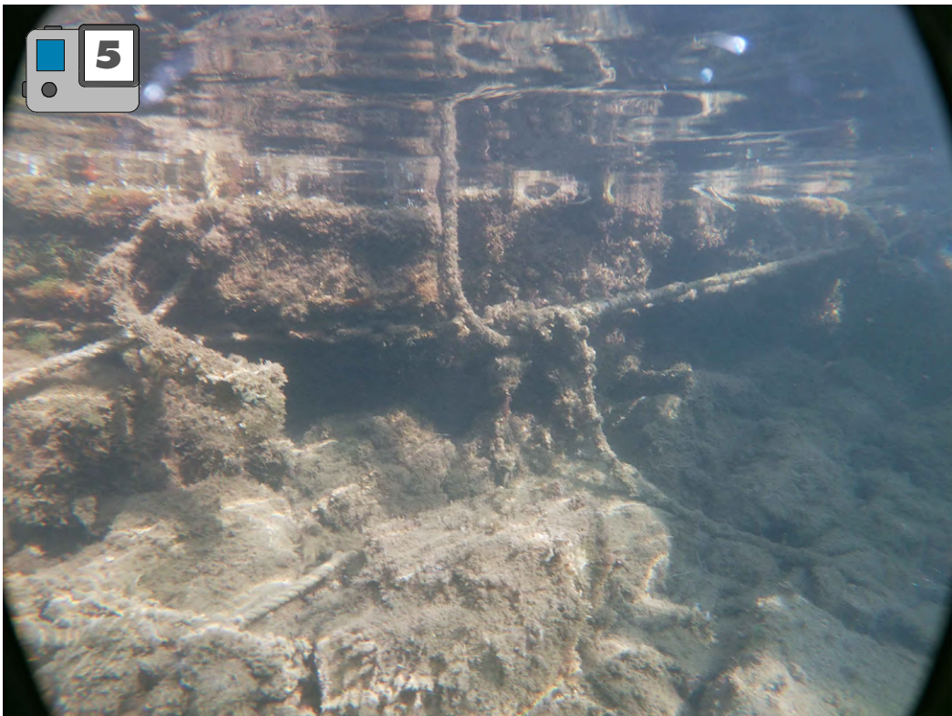
Les quais du Port du Manteau sont constitués d'enrochements de 200 kg à 500 kg empilés et liaisonnés par une dalle béton. Ils comportent de nombreux affouillements en pied d'ouvrage.
