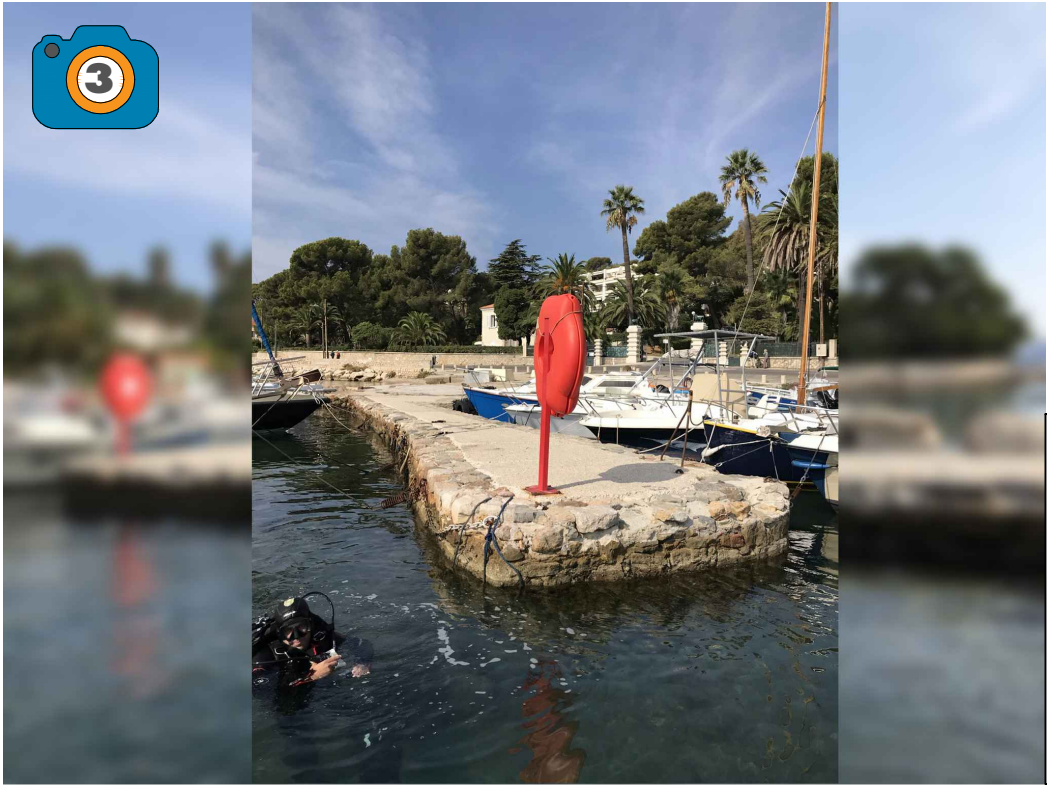
Contre digue réalisée en enrochements 200 à 500 kg maçonnés et surmontés d'une dalle béton. L'angle extérieur comporte un gros affouillement ainsi qu'une crevasse.
