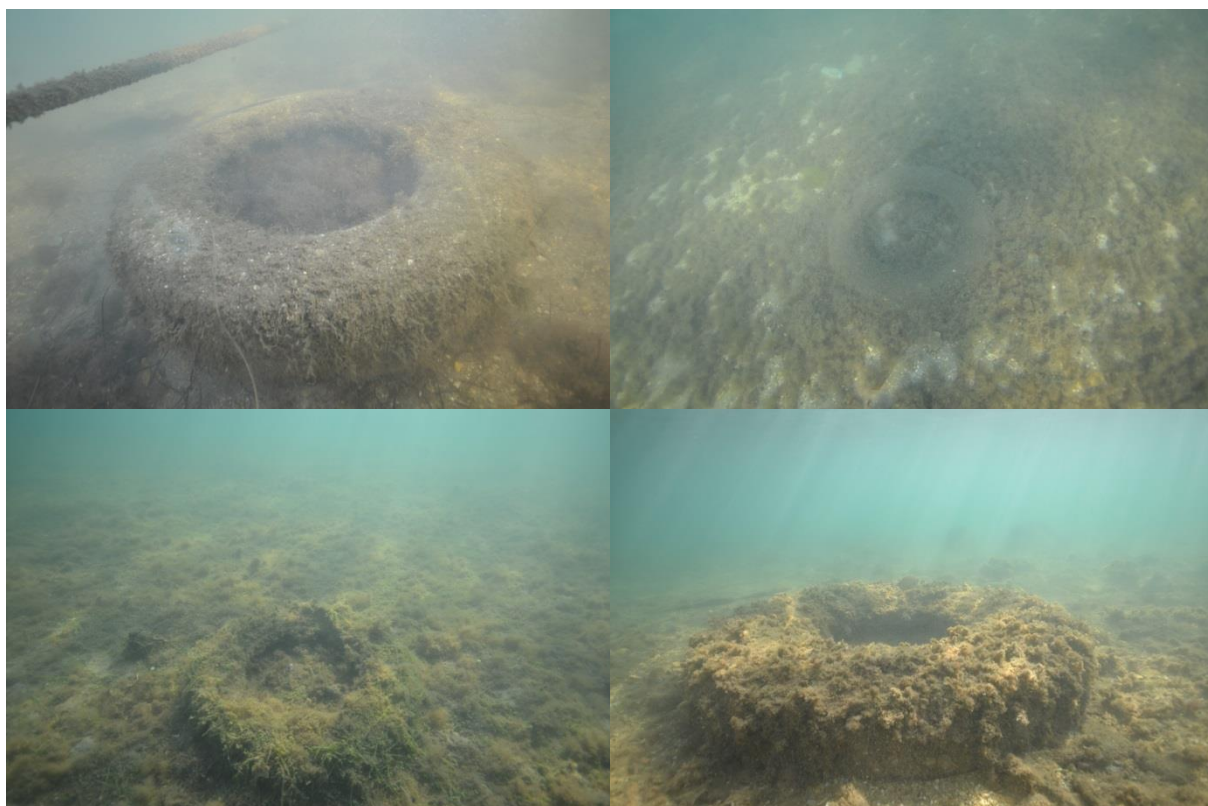
Figure 32 – Pneumatiques, certainement des défenses de quai qui se sont détachés © P2A Développement
