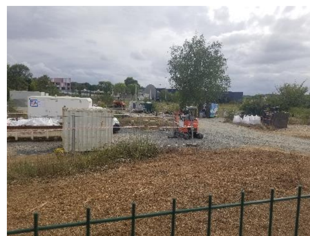
Base vie sur la partie Nord, à l'entrée du site
