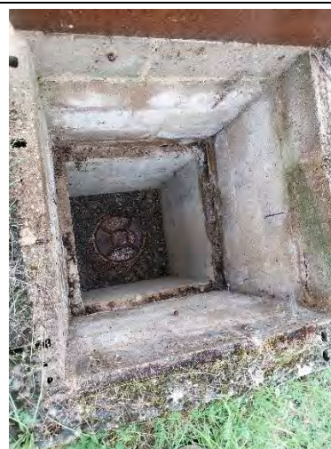
Photographie 4 : Trou d'homme - Cuve supposée d'hydrocarbures à l'ouest (6)
