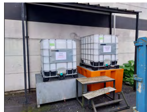
Cuve Aérienne de Huiles usagées
