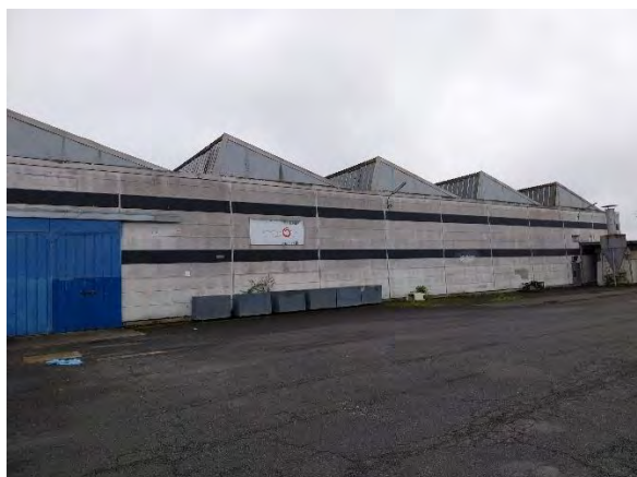
Photographie 3 : Façade du bâtiment Nord-Ouest
