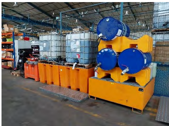
Photographie 19 : Cuve huiles neuves et glycols (Lot 2) (12)
