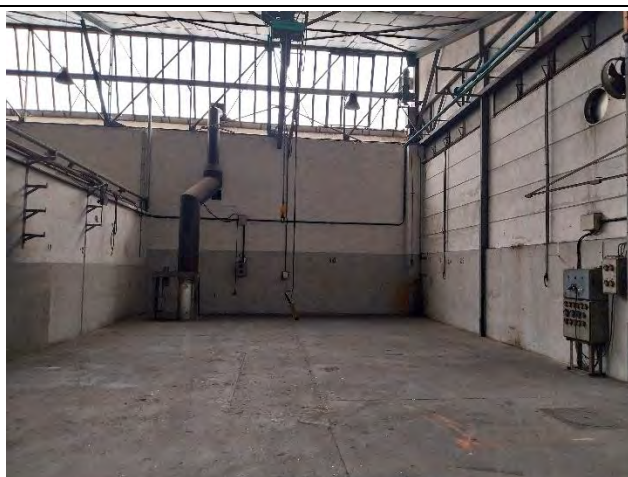
Photographie 13 : Zone ancienne presse hydraulique/atelier (Lot 3)
