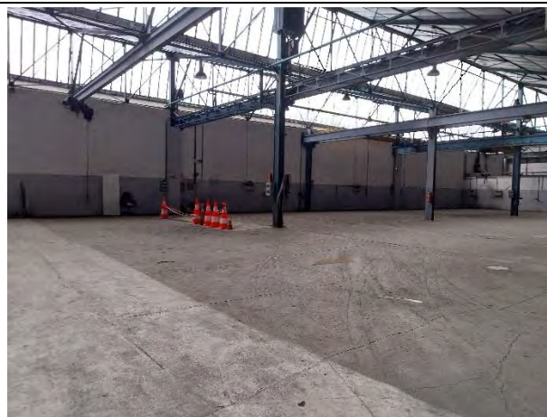
Photographie 8 : Intérieur Bâtiment Lot 3
