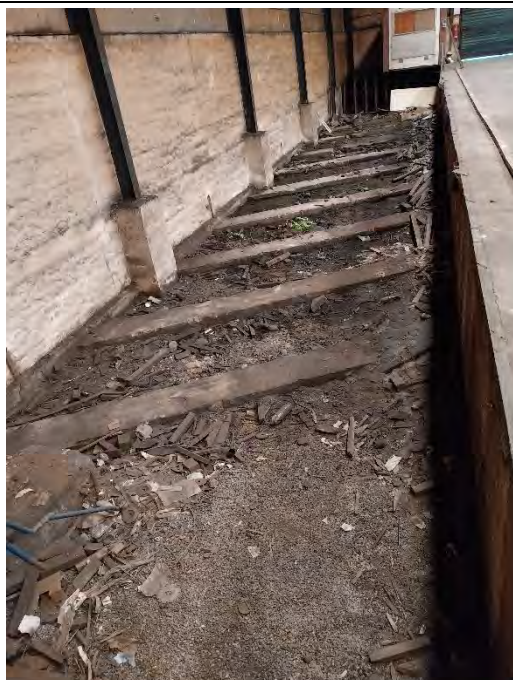
Photographie 29 : Voie ferrée (Lot 1) (12)
