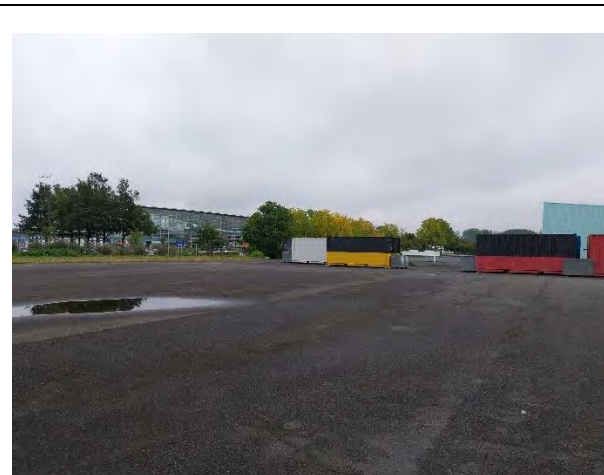
Photographie 16 : Parking Nord
