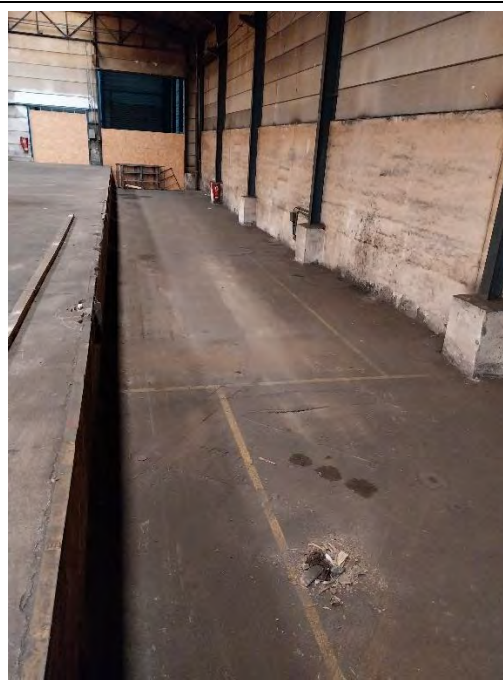
Photographie 30 : Voie ferrée recouverte d'enrobé (Lot 1)
