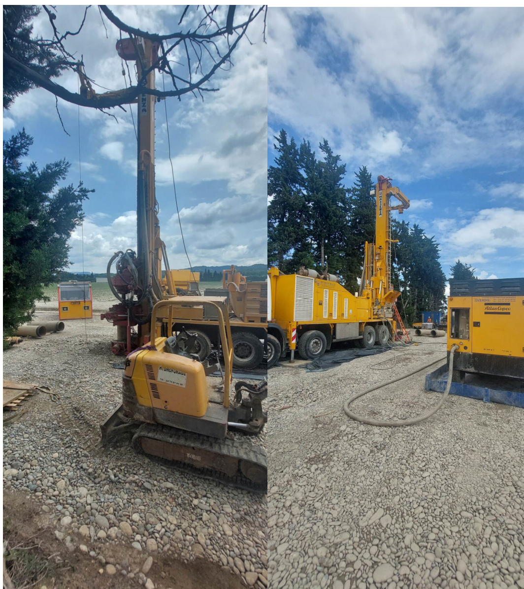
Figure 9 : Plateforme de chantier - F2
