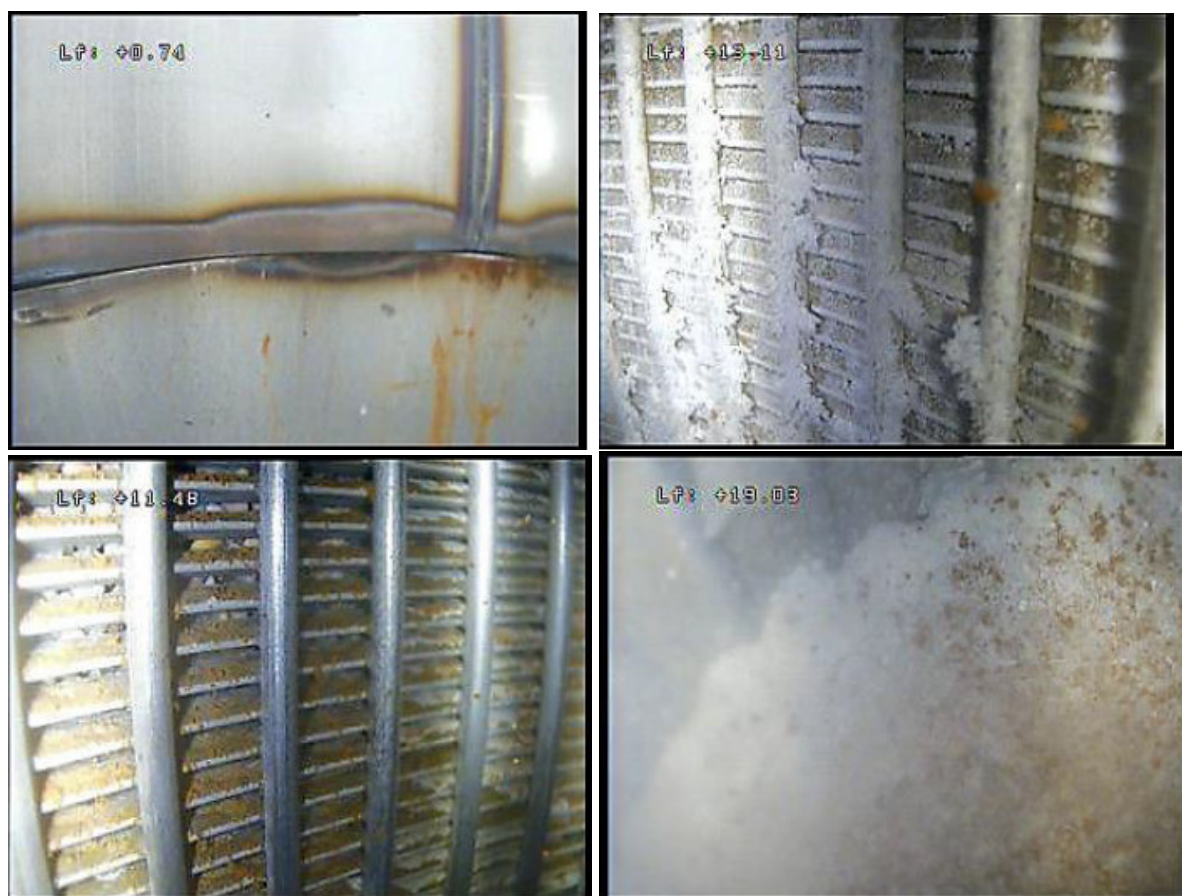
Figure 30 : Photos du passage caméra dans le forage F1
