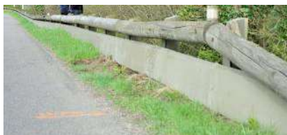
Figure 13. Exemples de glissières en bois (côte d'or)
