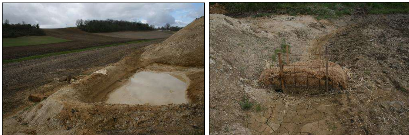
Figure 17 : Bassin de décantation temporaire des eaux de ruissellement en phase de chantier avec filtre à paille en sortie
