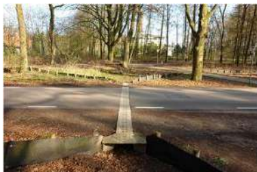
Figure 15. Exemple de glissières bois de part et d'autre du tunnel (F. Ottburg, Pays-Bas)
