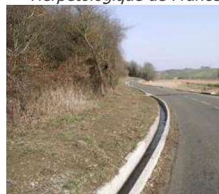
Figure 16. Exemple de gouttières (Suisse)
