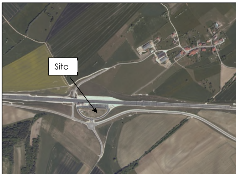
Figure 4 Vue aérienne (2007) et report approximatif du site (source remonterletemps.ign.fr)
