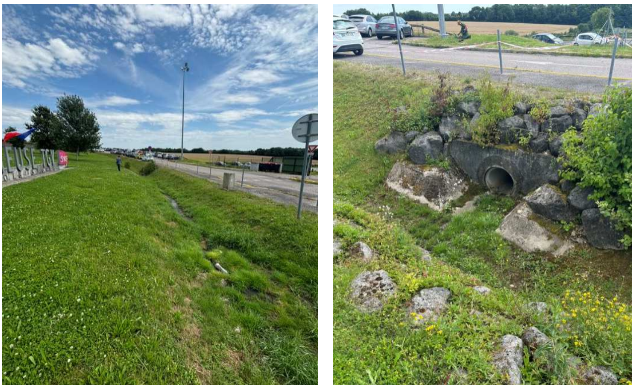
Figure 5 : Photos fossé Sud et tête de buse sous voirie vers le Sud
